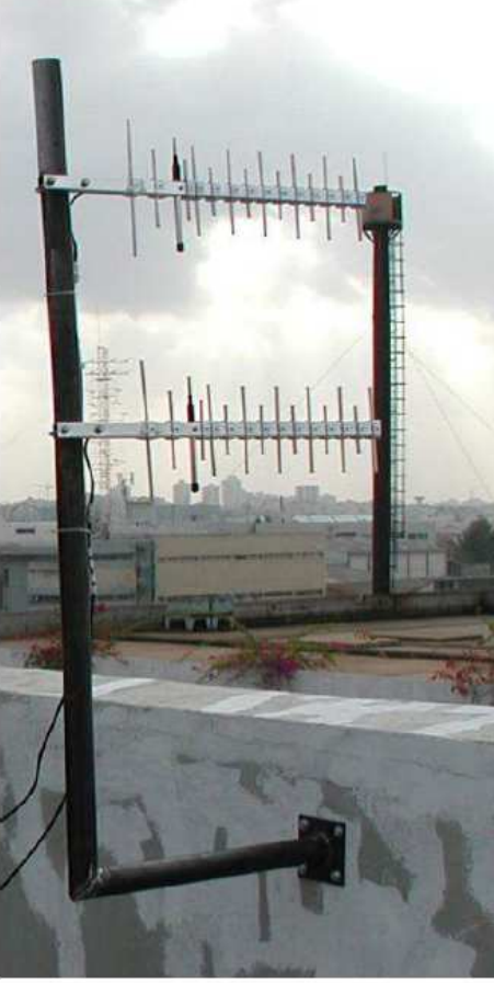
Şekil: Yön antenlerinin doğru kurulum örneği
